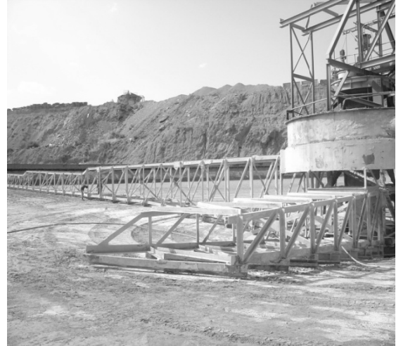
شکل (۱۷) نمایی از ریکهای تیکنر باطله مجتمع مس سرچشمه
